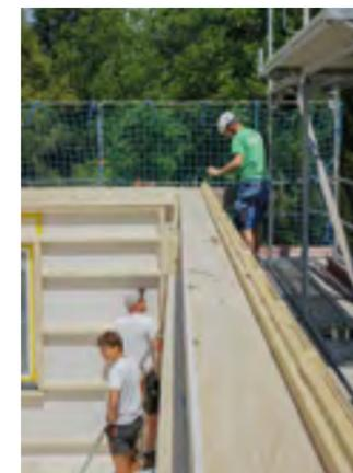
↑ Maßarbeit: Teil für Teil werden die vorgefertigten Module installiert. Fotos: Fichtl Holzbau
